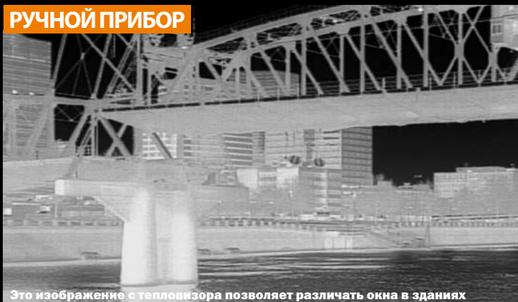
Это изображение с тепловизора позволяет различать окна в зданиях
